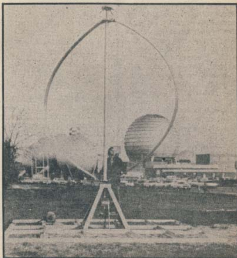
Figuur 14: Darrieus molen, zoals in onderzoek bij de NASA, Langley, (Amerika) en bij Fokker in Schiphol-Oost.
