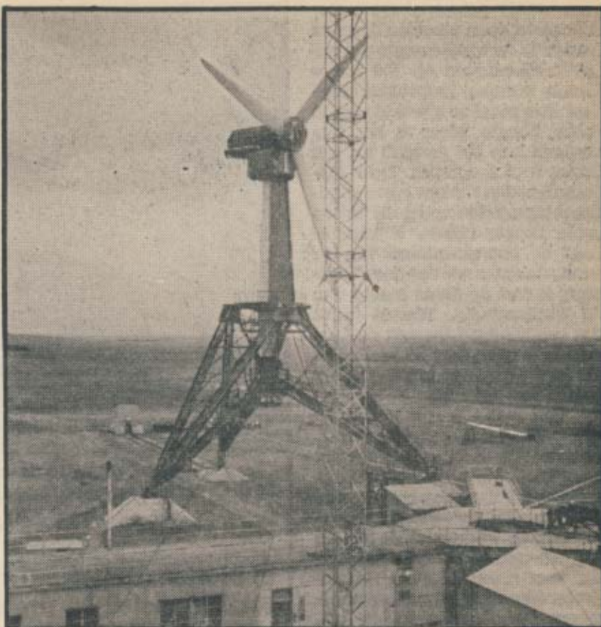
Molen in Nogent-le-Roi, Frankrijk met een diameter van 30,2 meter en een vermogen van 800 kW.
